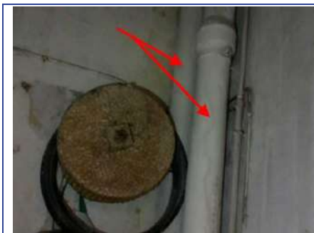
Photo n° PhA001 Localisation : R+1 - Annexe Ouvrage : Conduits de fluides (air, eau, autres fluides) Partie d'ouvrage : Conduits Description : Conduits Wc Localisation sur croquis : M001
