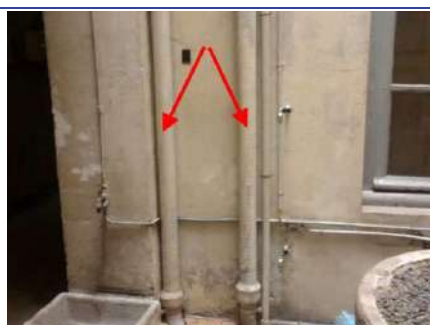
Photo n° PhA001 Localisation : RDC - Cour Ouvrage : Conduits en toiture et façade Partie d'ouvrage : Conduites d'eaux usées en amiante-ciment Description : Conduites d'eaux usées en amiante-ciment Localisation sur croquis : M001
