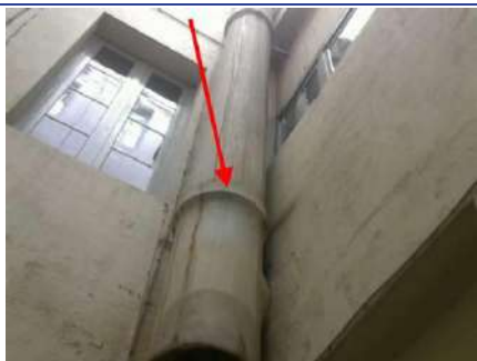
Photo n° PhA002 Localisation : RDC - Cour Ouvrage : Conduits en toiture et façade Partie d'ouvrage : Conduits de fumée en amiante-ciment Description : Conduits de fumée en amiante-ciment Localisation sur croquis : M002
